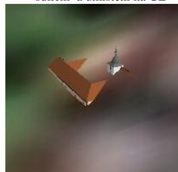
Obr. 84 b) Objekt v GE
