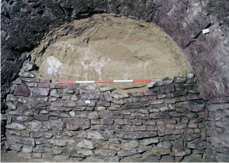
Obr. 9. Chrudim, Hradební ul. Detail odstraněné zazzdivky západního výklenku druhého patra sklepa. Foto J. Frolík. Abb. 9. Chrudim, Hradební-Gasse. Detail der entfernten Einmauerung der westlichen Nische des zweiten Kellergeschosses. Foto J. Frolík.
